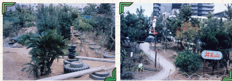
1992年 改修・盛土後の弁天山
