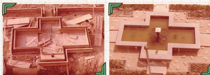
工事中と完成直後の十字池
