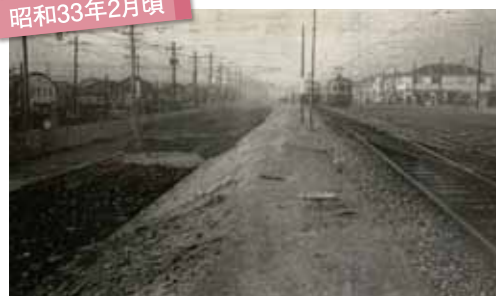
左に昔懐かしい八幡屋劇場が見えます。現在はロイヤルホストが在ります。右の白い建物の所には現在交番所が出来ています。
